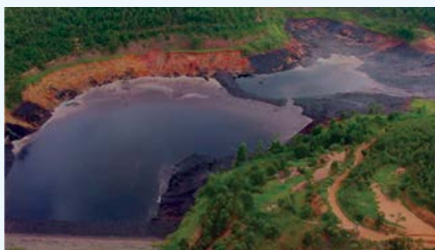
Figura B Rompimento de barragem com licor negro, em 2003, que atingiu o Rio Paraíba do Sul.
